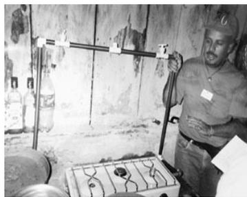
**Figura 1:** Instalación de una cocina de biogás.
