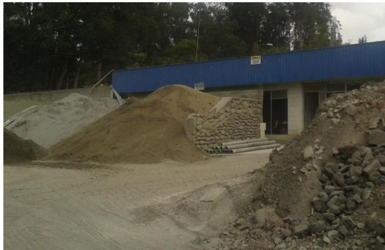
Figura 4: Almacenamiento de Agregado Grueso
