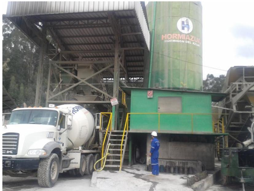
Figura 5: Silo de almacenamiento de Cemento
