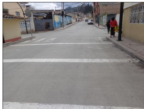
Figura 2.23: Paso peatonal entrada y salida Noroeste
