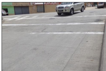
Figura 2.18: Paso peatonal entrada y salida Noroeste
