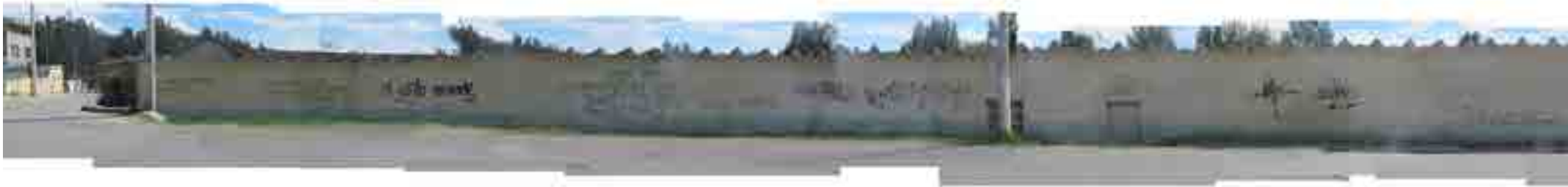
Fachada sobre la vía al Lazareto
