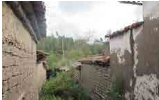
img.39: Pasarela entre muro de pabellones fuente: El autor
