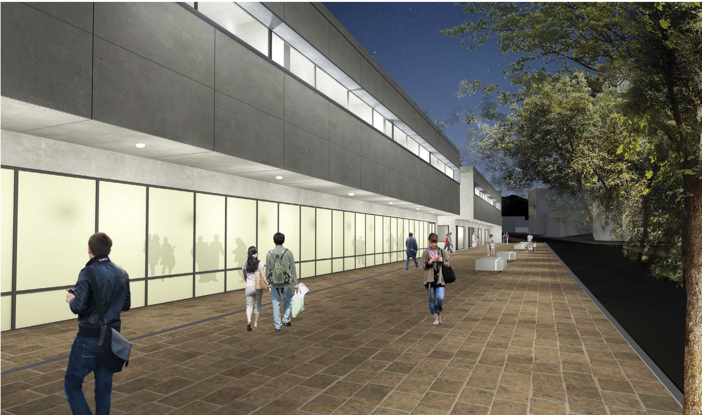
Fachada del proyecto. Planchas de fibrocemento de 1,22x2,44 separadas por junta.
