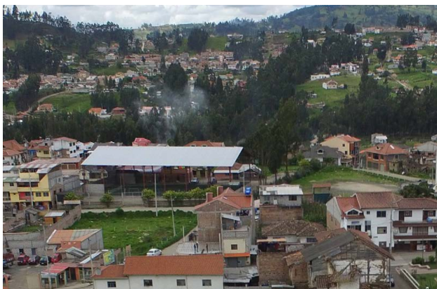
Imagen 2. Impacto de canchas privadas (Fotografía propia)
