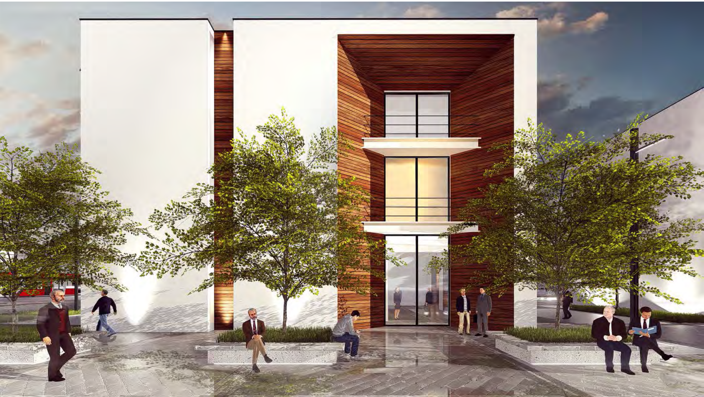
La fachada del proyecto se resuelve en madera y enlucido pintado de blanco.
