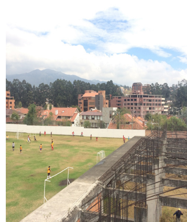
Interior estadio Cashapata (infraestructura en mal estado) fuente foto: fotos propias
