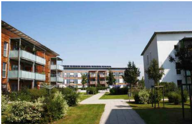
imagen8. Viviendas del proyecto Solar City http://camuniso.blogspot.com/2011/05/solar-city-linz-austria.html
