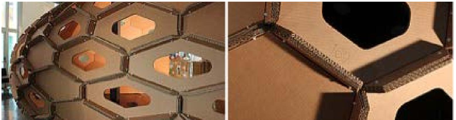
Imagen 5: Caparazón de cartón- Coocoon, imitación de la forma de un panel
