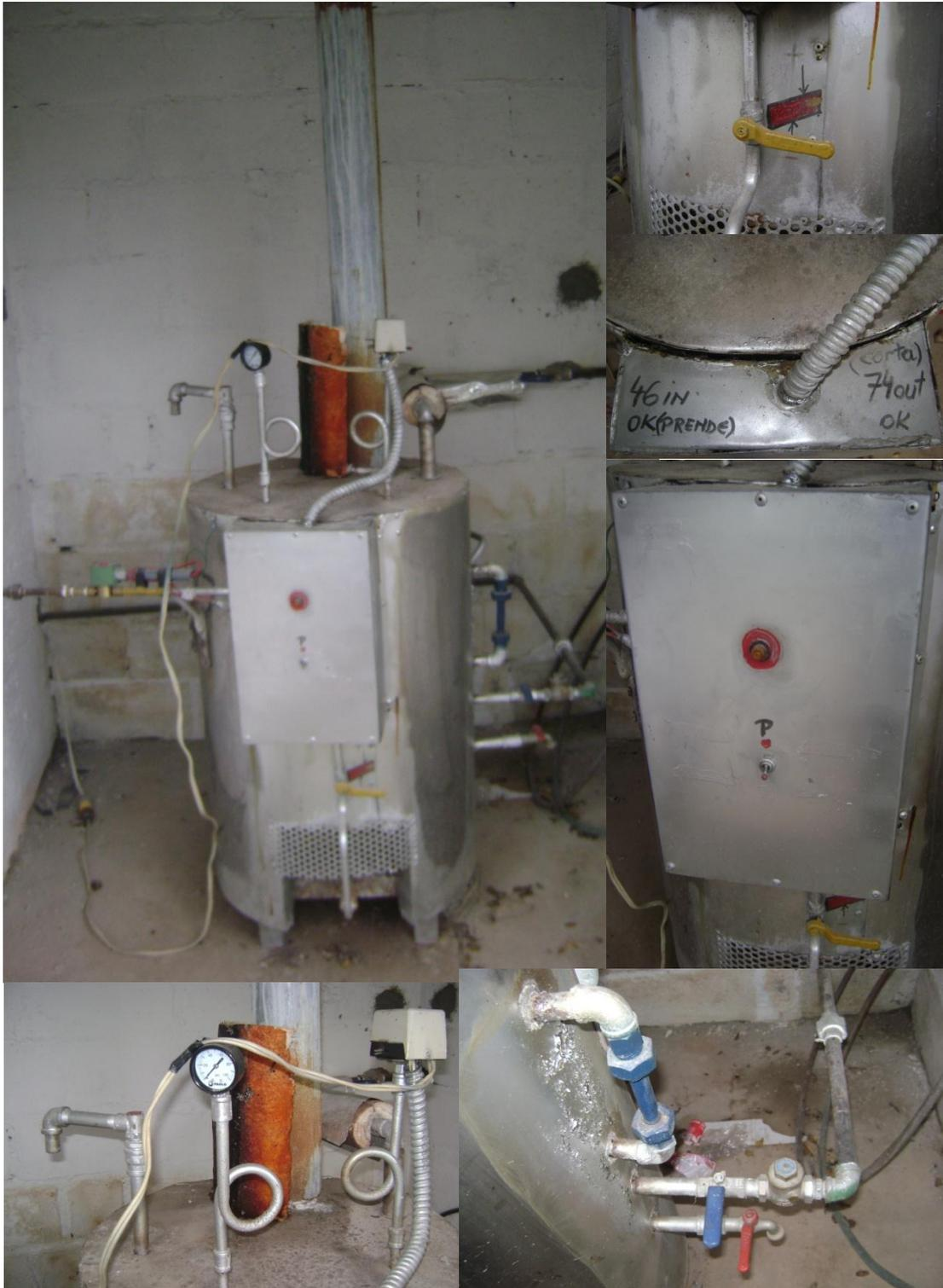
Las instalaciones de vapor no contaban con las características necesarias para el transporte del vapor produciéndose condensaciones en la parte externa y defectos en el aislamiento a lo largo de la distribución interna en la planta. Las áreas de procesamiento de semi-elaborados tampoco contaban con vapor suficiente para la desinfección de superficies. La pérdida por la mala inversión en este equipo fue de \$3000usd.
