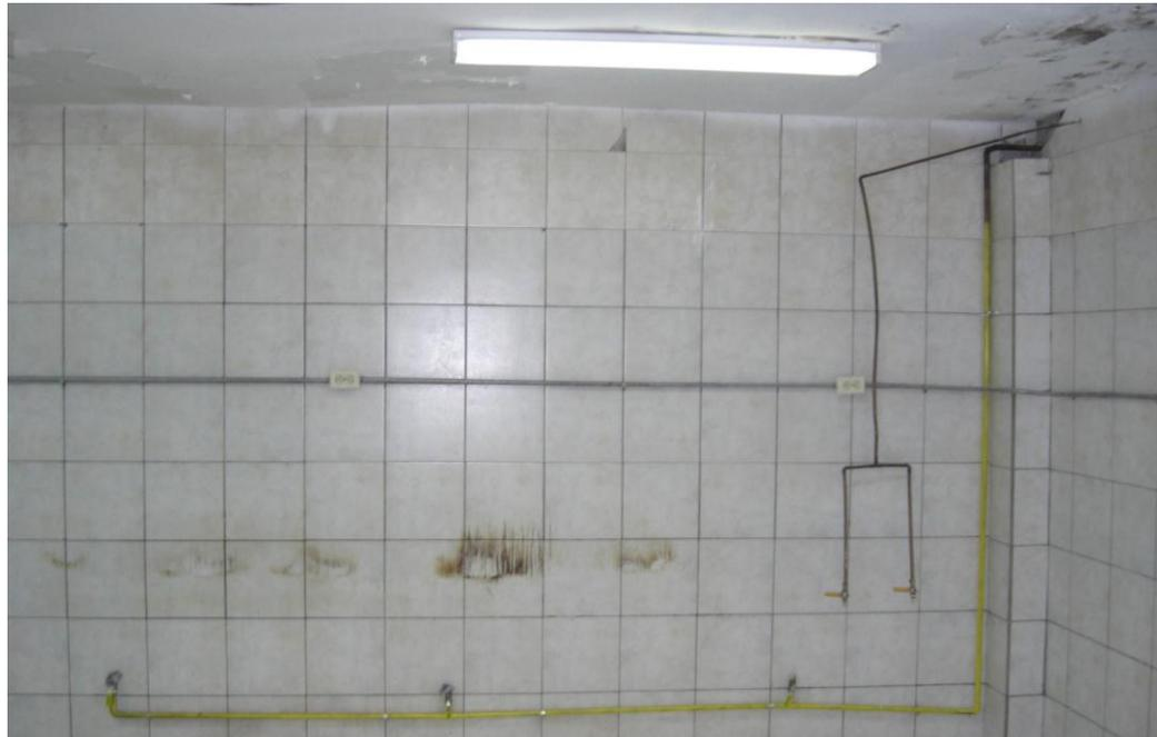
Figura N°53. Instalación centralizada de gas con 3 salidas para cocina industrial. Noviembre, 2010.
