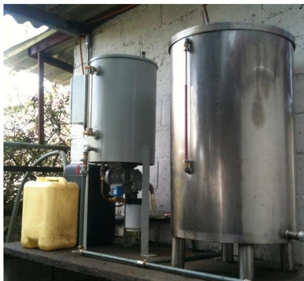
Figura N°56. Filtro de diesel y tanque alimentador. Enero 2011.
