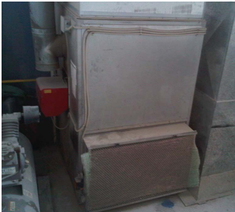
Figura 2.17 Prefiltro y electroventilador de succión.
