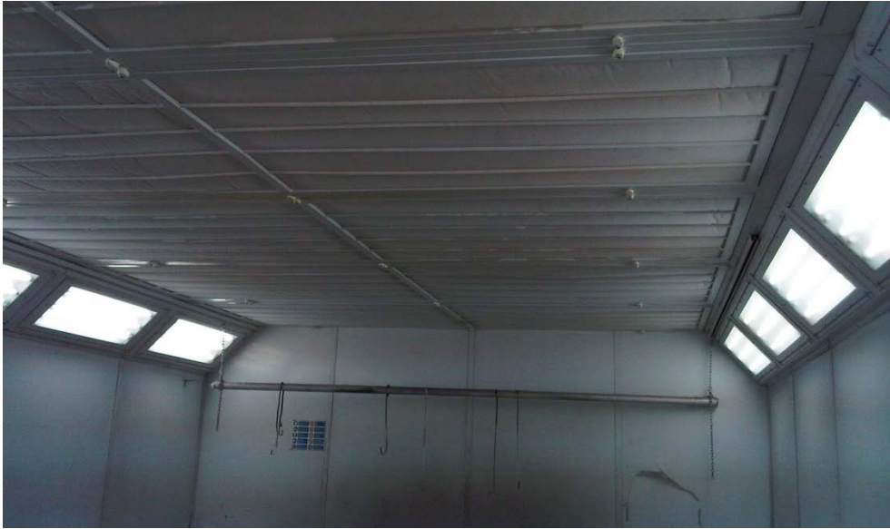
Figura 2.22 Disposición de lámparas fluorescentes de neón dentro de la cámara. Fuente: Talleres Mirasol S.A. Cuenca
