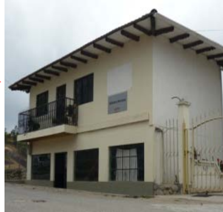
PARTE EXTERIOR DE LA BIBLIOTECA
