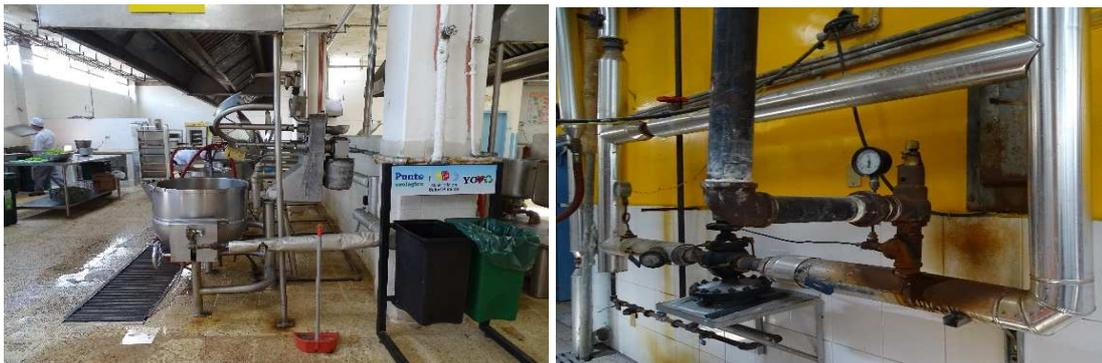
Figura 2.31: Fugas de vapor en la cocina y lavandería.
