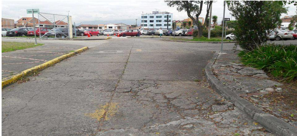
Figura 2.17: Levantamiento de la losa de hormigón debido a las raíces de los árboles.
