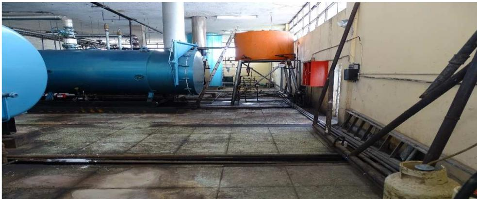
Figura 2.28: Cuarto de máquinas (calderas y depósito de combustible)
