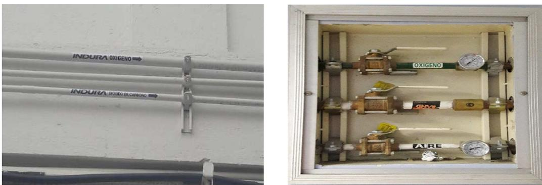
Figura 2.30: Condición de las tuberías de gases medicinales exterior e interior.
