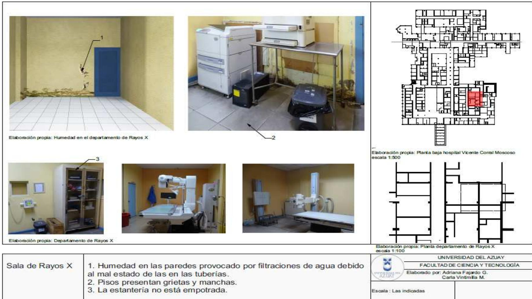
Figura 4.11: Humedad en paredes.
