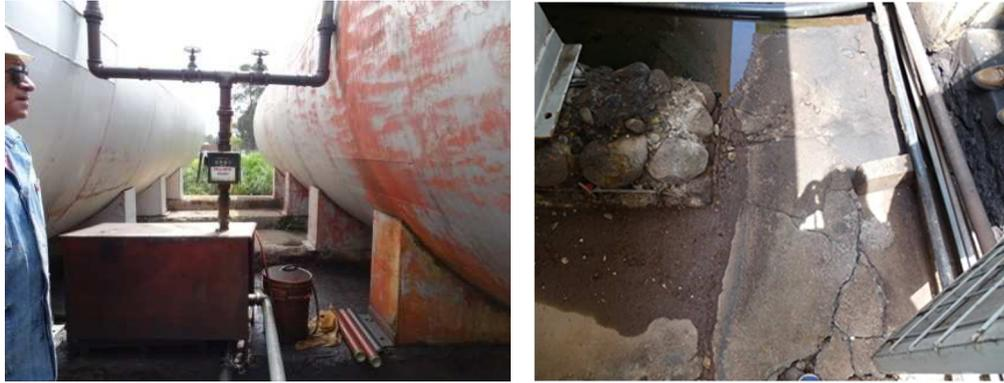
Figura 2.27: Almacenamiento de Diésel (Apoyos en mal estado)
