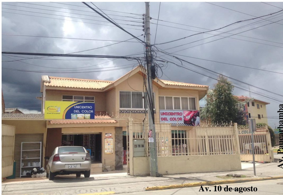
Imagen 2. Infraestructura Unicentro del Color
