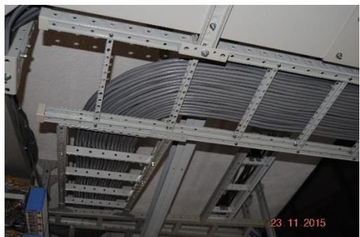
Figura 2. 115: N. Arenal. Escalerillas
