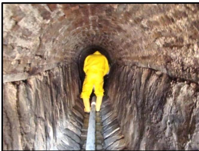
Durante el recorrido al interior de El Gallinazo se pudo constatar entre otras cosas que: el colector todavía continúa prestando utilidad, aunque en porcentaje ínfimo; el material residual putrefacto tenía un espesor entre 35-50cm de espesor; en algunos sectores, la tubería colocada en el fondo del colector facilitó nuestro recorrido, tal como ilustra la fotografía que se adjunta
