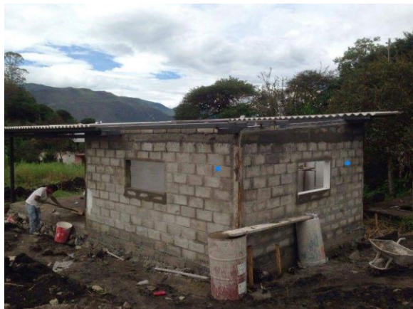
Figura 4.8 Finalización de la construcción del cuarto de máquinas Fuente: (Autoría Propia)
