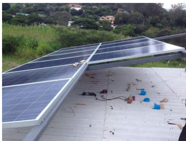
Figura 4.9 Instalación de los primeros 10 paneles fotovoltaicos Fuente: (Autoría Propia)
