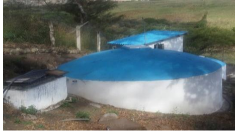
Figura 3.1 Tanques de reserva de 30.000L contruidos para el desarrollo del proyecto Fuente: (Autoría Propia)
