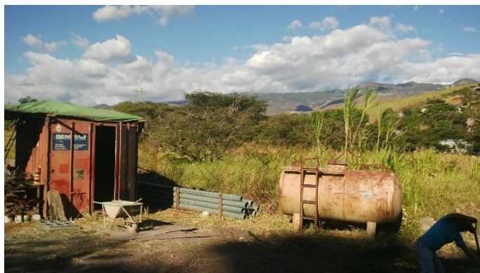
Figura 4.6 Inicios de los trabajos de construcción de cuarto de máquinas Fuente: (Autoría Propia)
