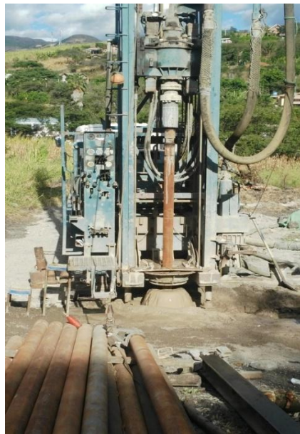
Figura 3.3 Perforación y pruebas de bombeo por parte de la prefectura del Azuay Fuente: (Autoría Propia)
