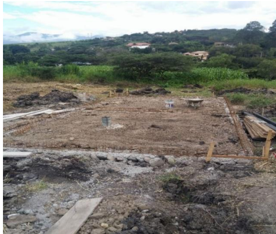
Figura 4.7 Construcción de cuarto de máquinas Fuente: (Autoría Propia)
