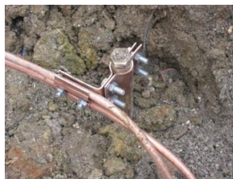
Figura 2. 13 Anillos en puesta a tierra. Fuente: GARCÍA 2015
