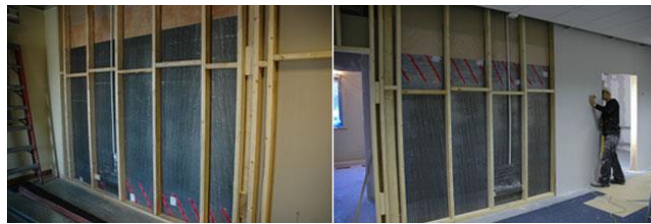
Figura 1. 14 Instalación de Acero en Paredes. Dosimetría y Blindaje. (n.d.). Fuente: http://www.proteccionradiologica.cl/dosimetria-blindaje.php
