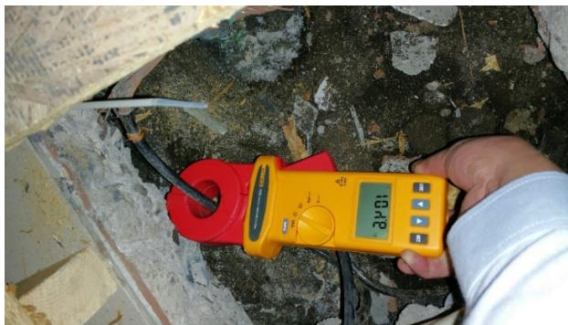
Figura 2. 20 Medición de tierra. Fuente: Autor
