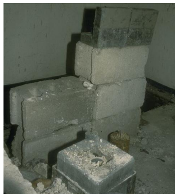
Figura 1. 15 Paredes de Hormigón. Fuente: Autor
