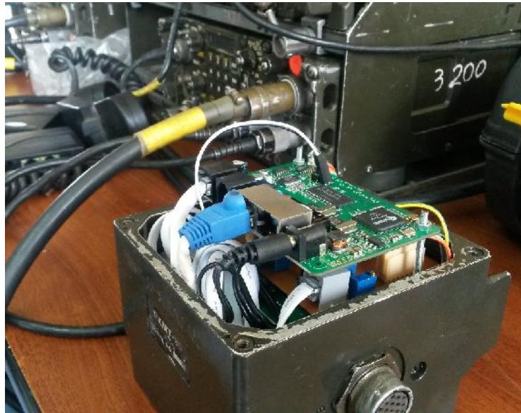
Figura 5.11 Placa interface y placas de los RoIP colocadas dentro de la caja del relé.
