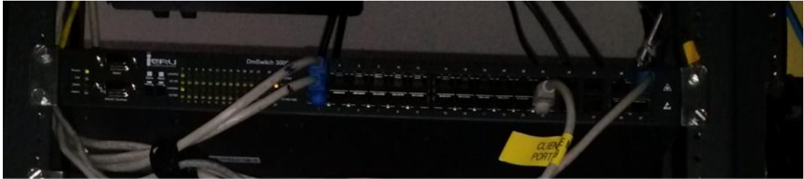
Figura 3.5 Switch para interconexiones.
