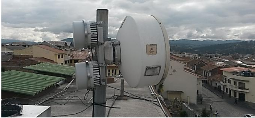
Figura 3.10 Módulos ODU y antena de radioenlace.
