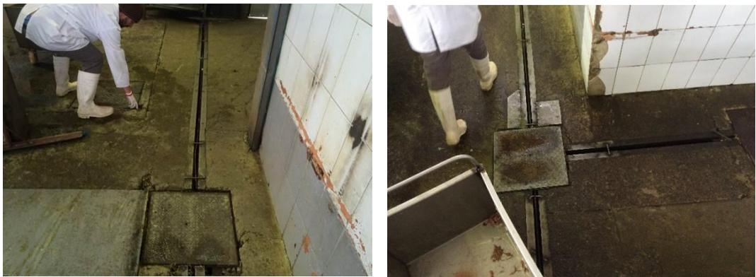
Figuras: 4.9 y 4.10. Cajas de revisión con canastillas para la retención de sólidos
