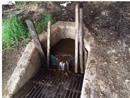
Figura: 6.2.1. Vertedero de medición triangular.
