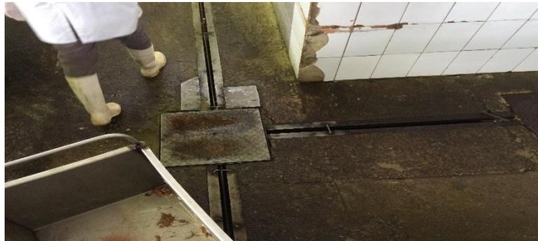
Figura: 4.6. Canal y caja de recolección interna, sistema de canales
