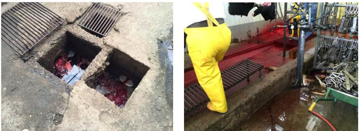
Figuras: 4.5.1 y 4.5.2. Cajas de recolección y conducción de sangre a la planta de compostaje
