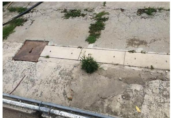
Figuras: 4.7 y 4.8: cajas de recolección para el emisario final hacia las unidades de tratamiento de efluentes líquidos, las cuales sufren taponamientos, debido a la gran cantidad de sólidos que acarrea las aguas de proceso y que deben ser retenidas en su origen
