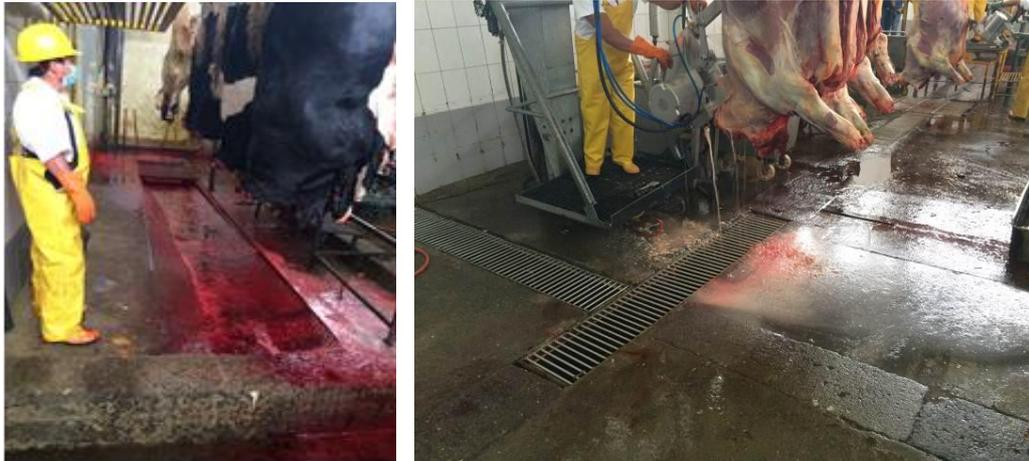
Figuras: 4.1 y 4.2 desangre e izado del animal y canales de recolección de las aguas de proceso, los cuales funcionan adecuadamente. Los pisos necesitan mantenimiento constante.
