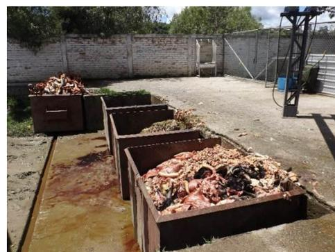
Figuras: 6.2.4 y 6.2.5. Se cuentan con 7 contenedores metálicos de 6 m<sup>3</sup> cada uno, es decir se tiene una capacidad de almacenamiento de alrededor de 42 m<sup>3</sup>
