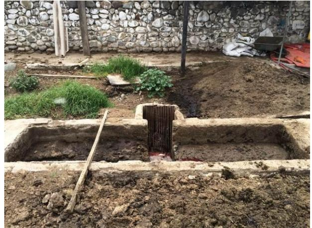
Figuras: 5.3.1 y 5.3.2. Decantador primario completamente colapsado
