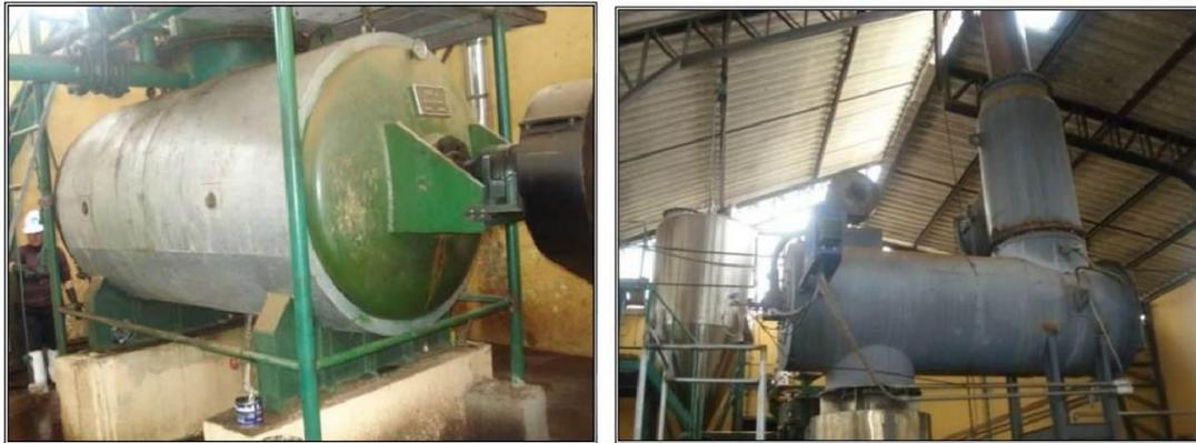
Figuras: 7.2.1 y 7.2.2. Tanque de evaporación y tanque de incineración en el camal de riobamba
