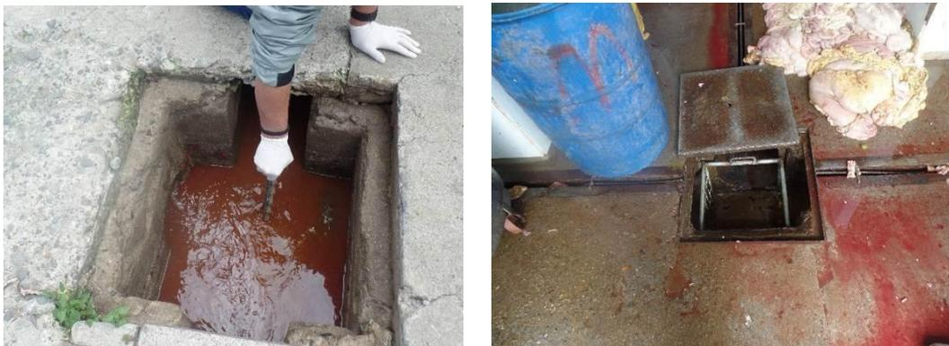
Figura: 7.2.3 y 7.2.4. Lugar recomendado para la instalación de una canastilla mecánica y canastilla instalada en el área de lavado de vísceras.
