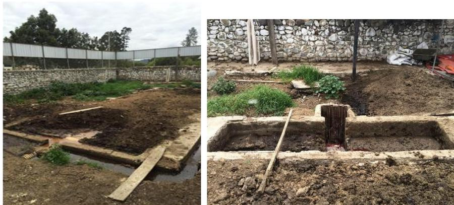
Figuras: 6.3.7 y 6.3.8. Decantador primario completamente colapsado
