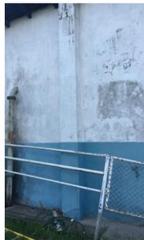
Figura 2.9 Columna de hormigón armado 40x40 cm.
