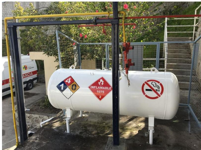
Figura 2.10 Bombona de gas centralizado.
