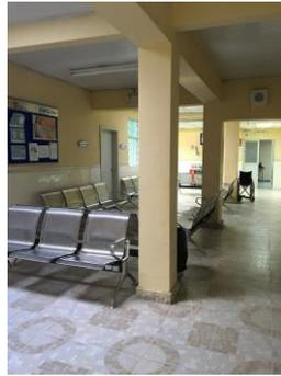
Figura 2.8 Columna de hormigón armado 35x35 cm.
