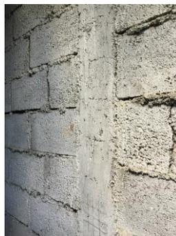
Figura 2.7 Columna de hormigón armado 20x20 cm.
