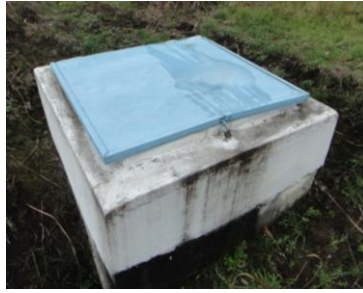
Figura 1.28 Vista frontal de la válvula de purga 1 de conducción
