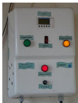
Figura 1.51 Panel de control de la máquina de cloración
