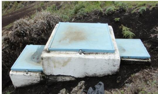
Figura 1.30 Vista frontal del tanque rompe presión 2 de la conducción
