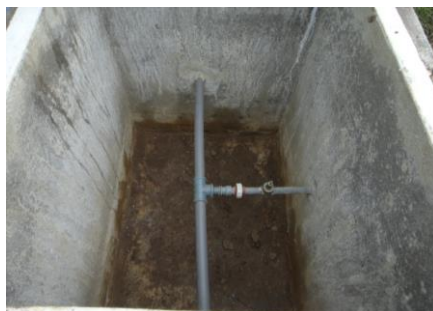
Figura 1.40 Interior de la válvula de purga 4
