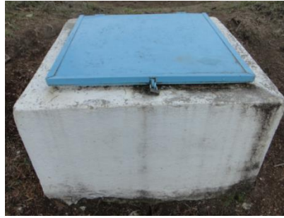
Figura 1.37 Vista frontal de la válvula de aire 1
