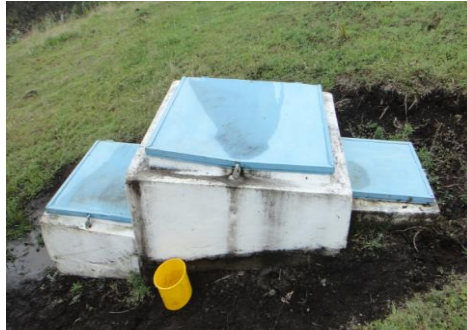
Figura 1.29 Vista frontal del tanque rompe presión 1 de la conducción
