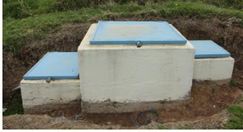
Figura 1.41 Vista frontal del tanque rompe presión 2
