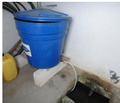
Figura 1.53 Proceso de cloración en la planta de tratamiento
