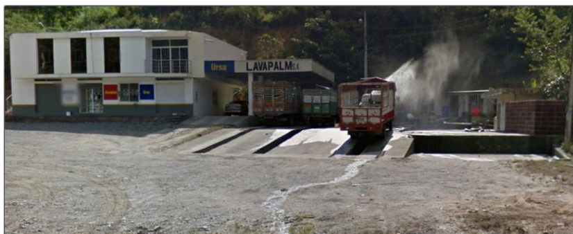
Figura 2.8: Lavadora y lubricadora LAVAPALM S.A Nota: Coordenadas geográficas 3°40'30.3"S 79°51'41.9"O Fuente: (Google.com.ec, 2016)
