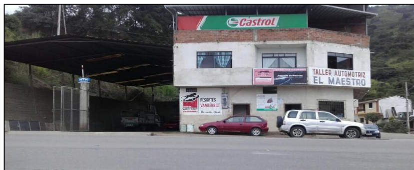
Figura 2.15: Mecánica automotriz, propiedad del Sr. Crespo Fausto Nota: Coordenadas geográficas 3°41'21.3"S 79°40'03.0"O
