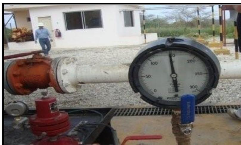
Fotografía 1.12. Presión a la salida del compresor
