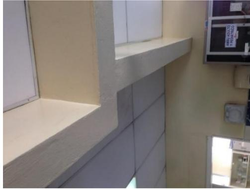
Figura 1.23: Falta de columna y excentricidad de vigas en emergencia
