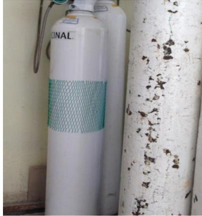
Figura 1.37: Falta de anclaje en los tanques de oxígeno
