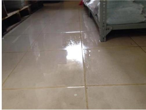
Figura 1.14: Piso, filtración de agua, área de bodega
