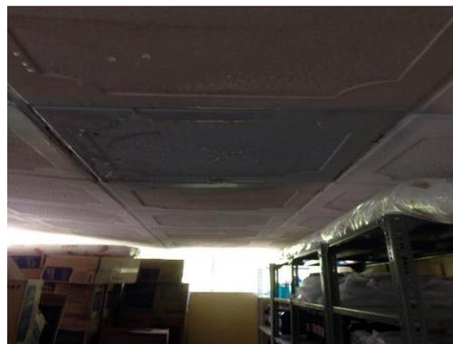
Figura 1.13: Cielo raso, filtración de agua
