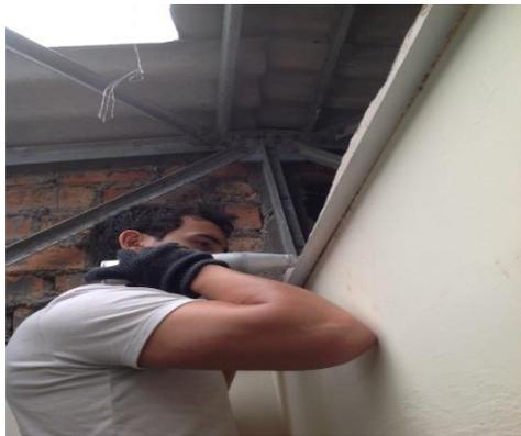
Figura 1.26: Prueba de esclerometría, emergencia
