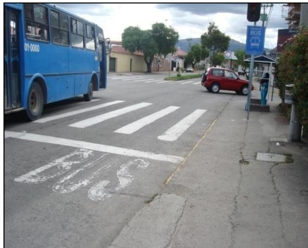
Figura 4.13. Colocación incorrecta de la señalización horizontal.
