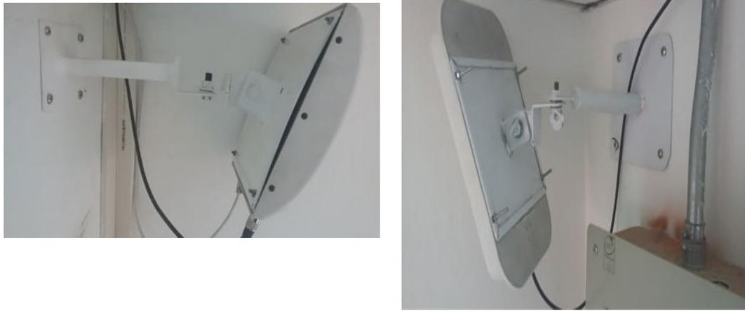
Figura 3.5 Soporte de los equipos de adquisición RFID.
