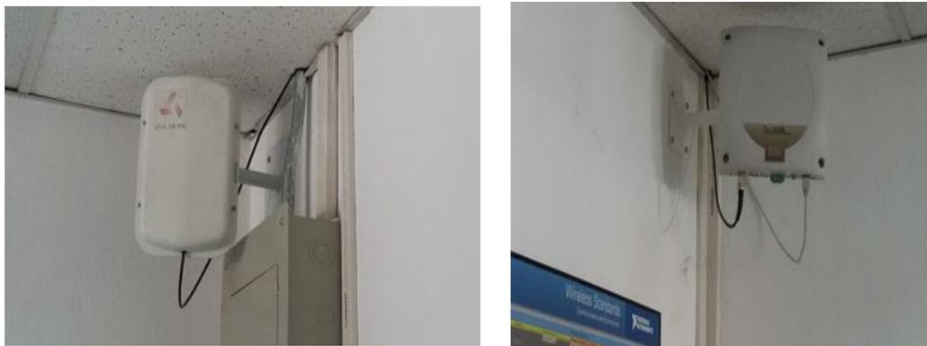
Figura 3.6 Equipos RFID instalados en el laboratorio de Telecomunicaciones.
