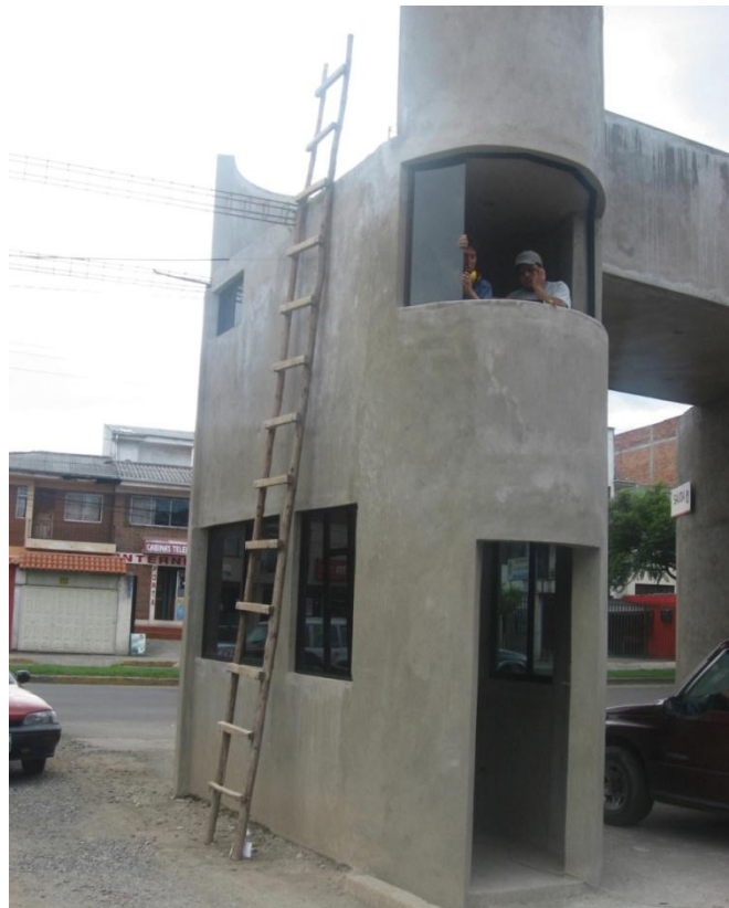
Figura #11. Garita de Seguridad.
