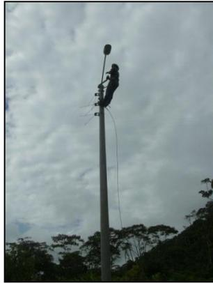
En lo que se refiere a vestir los tensores se coloca el cable tensor desde el poste hasta la varilla de anclaje.
