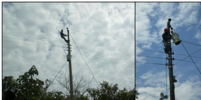
Figura 23: Instalar equipos (medidor).
