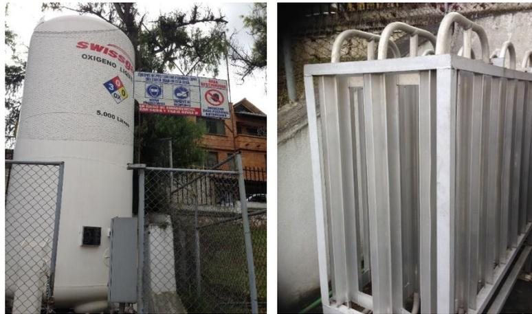
Figura 1.20: Tanque criogénico y tuberías de distribución de oxígeno
