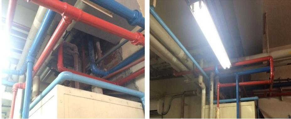
Figura 1.18: Tuberías de agua fría, caliente y vapor.
