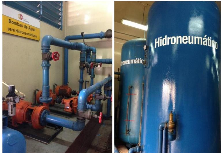
Figura 1.17: Bombas y sistema de hidroneumáticos
