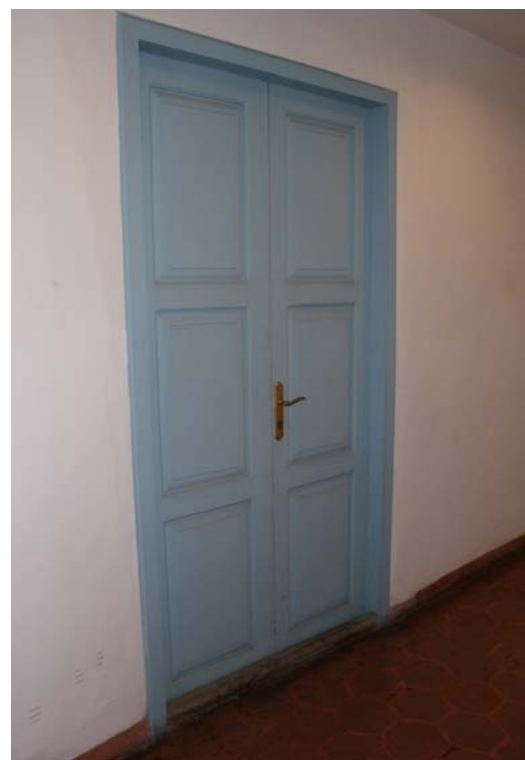
Puerta del depósito, vista exterior
