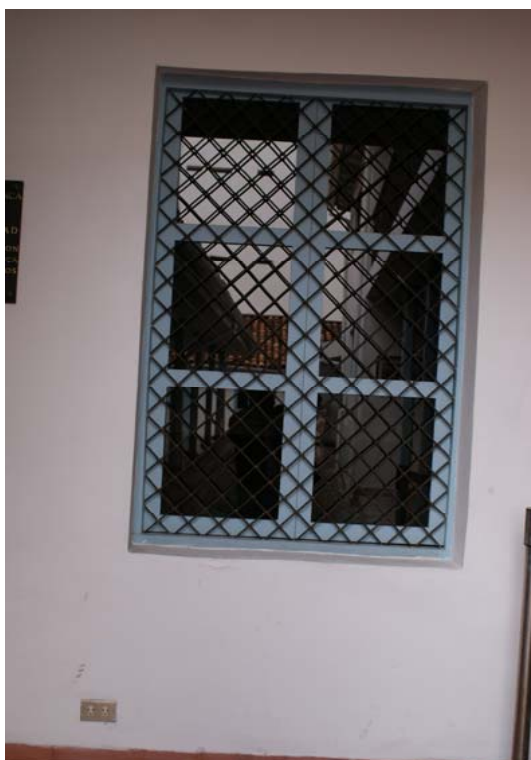
Ventana del depósito, vista exterior
