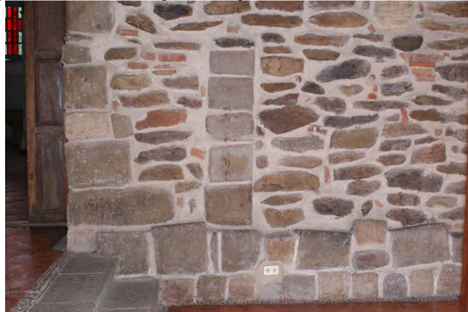
Pared con piedras Incas de Pumapungo. Fuente: Patricio Cáceres V. (2009)
