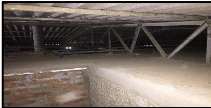
Figura 2.18: Tuberías de distribución de agua potable
