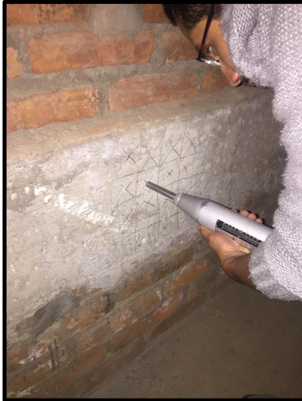
Figura 2.12: Ensayo esclerométrico en viga
