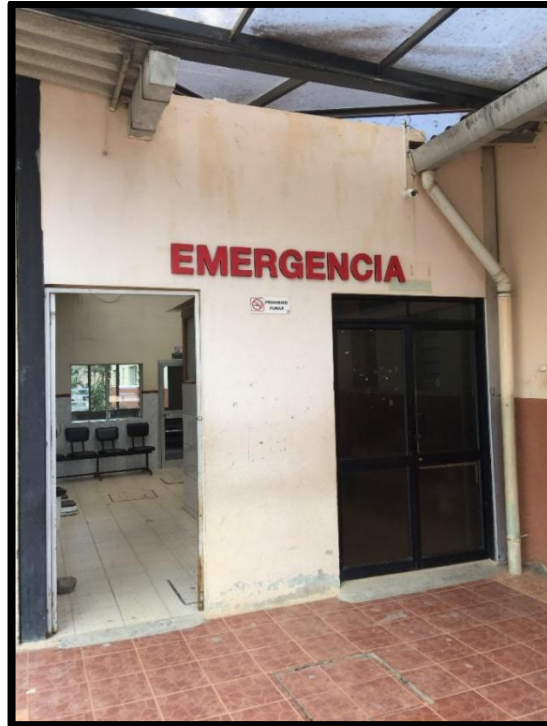
Figura 2.27: Canales de recolección de agua lluvia al interior de la sala de espera
