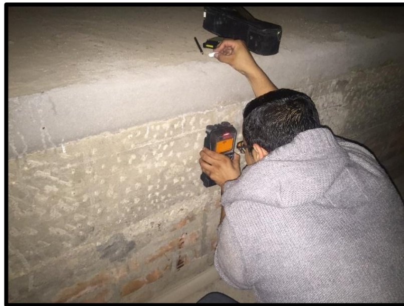
Figura 2.15: Ensayo con scanner en viga
