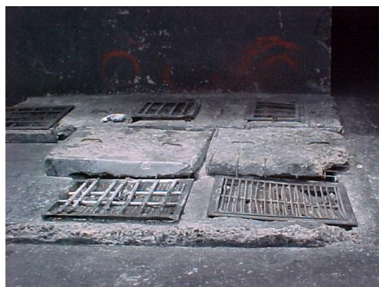
**Fig. 10.** Pozo Recolector de Lechada
