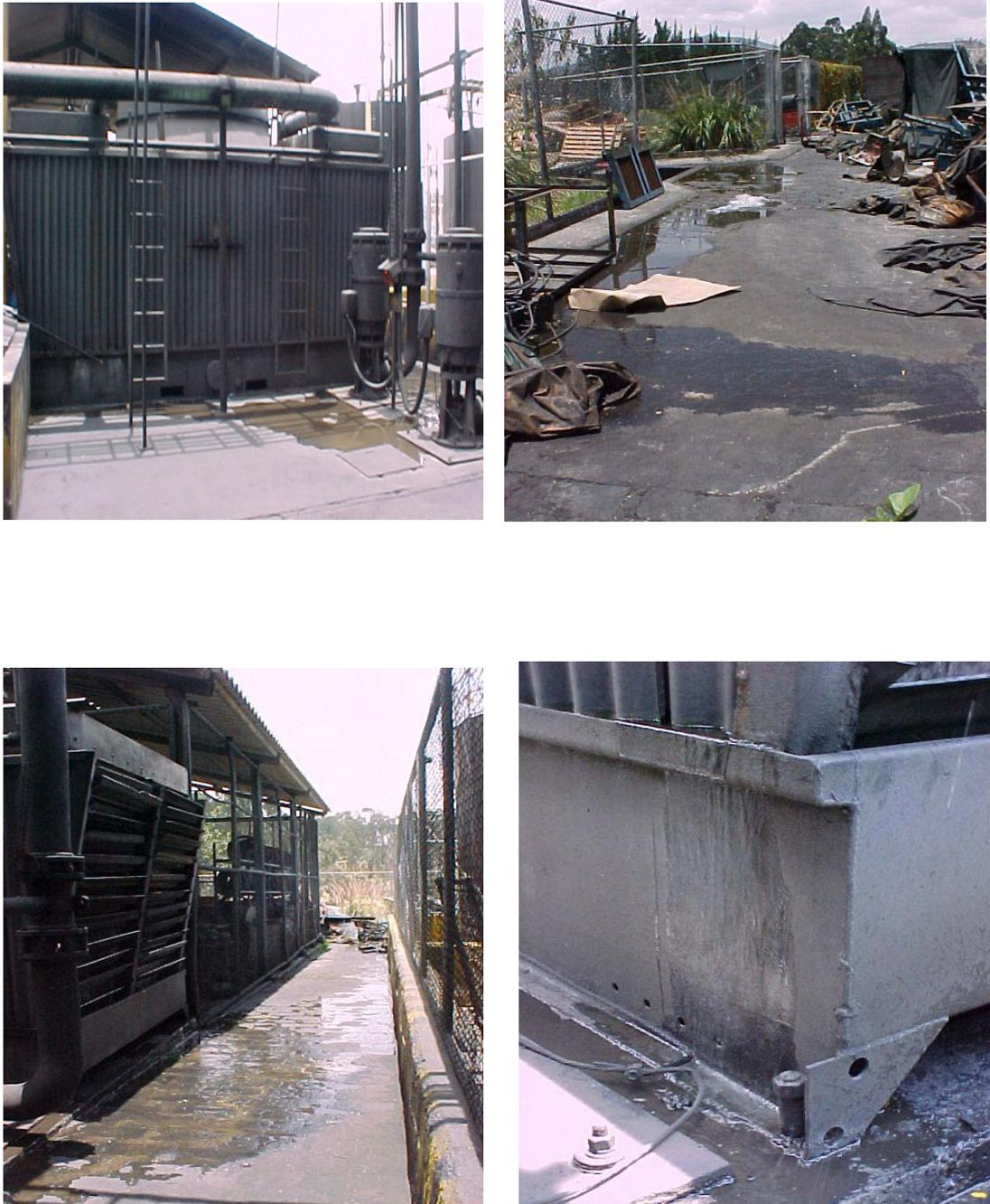
**Fig. 23** Fugas Externas de Torre
