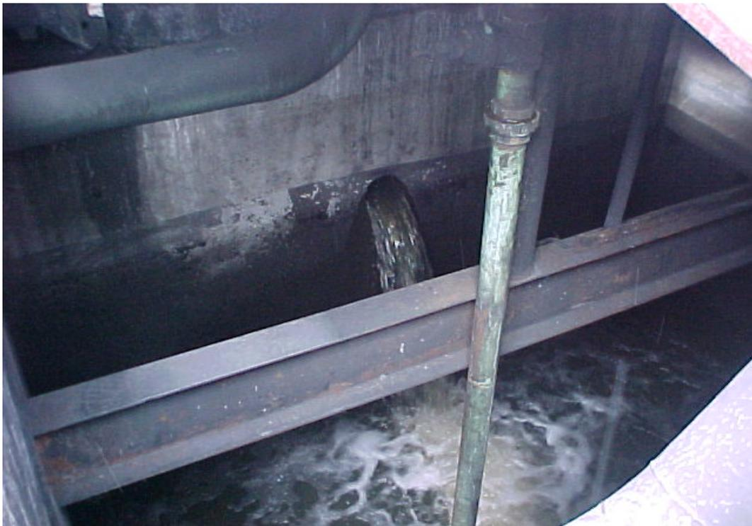
**Fig. 22** Ducto limitante de agua del pozo C enviando excedente de agua hacia el pozo A
