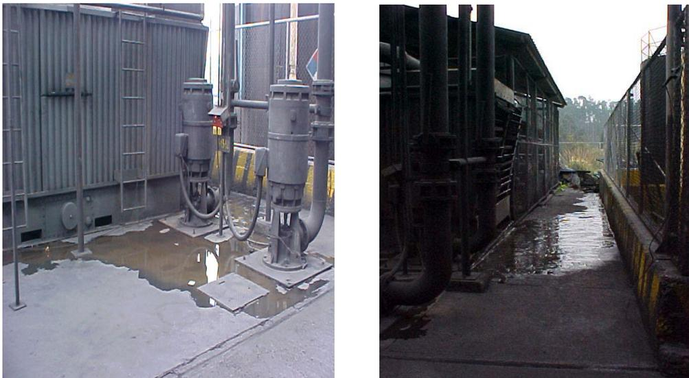
**Fig. 16** Fugas Torre de Enfriamiento # 3
