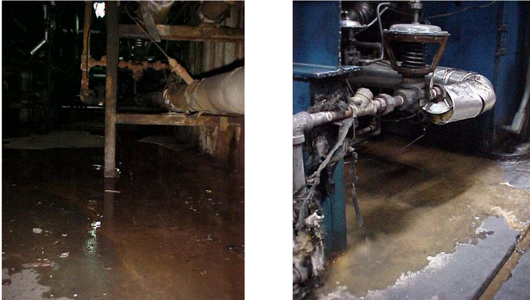
**Fig. 11** Condensado No recuperado Prensas Vulcanización
