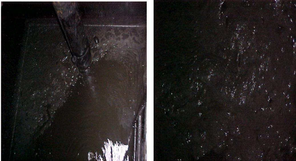
**Fig. 20** Acumulación de Bacterias en el pozo de la Torre
