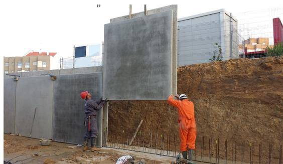
Figura 4.10 Colocación de uno de los paneles que conforman el muro prefabricado
