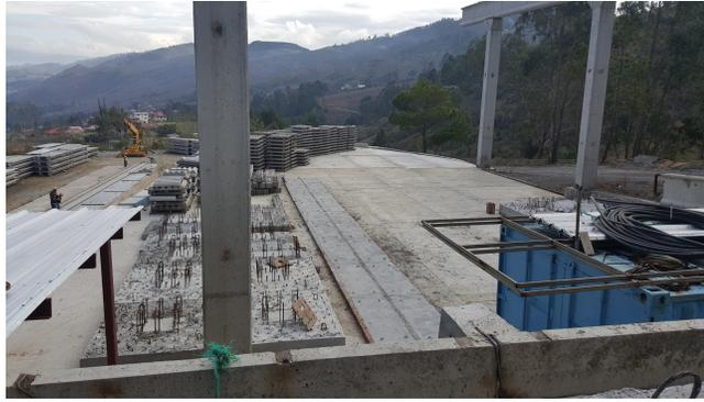
Figura 2.11 Área de almacenamiento de losetas y losas prefabricadas
