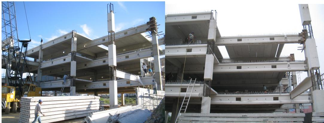
Figura 6.40 Disposición de columnas y vigas prefabricadas
