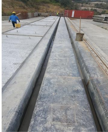
Figura 2.8 Encofrado de concreto, ser molde para losas DT
