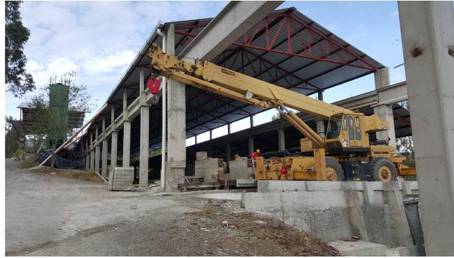
Figura 2.10 Equipo para el montaje de los miembros estructurales prefabricados
