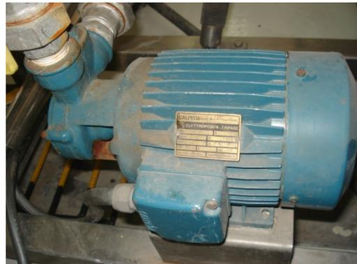
Fotografía 3.2 **Bomba de alimentación de agua caliente** (*fente: foto tomada de los laboratorios de lácteos de la Universidad del Azuay*)
