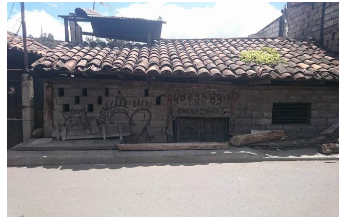
6-001-02. Acercamiento a Herrería 2 Foto tomada por: Yolanda Ortiz
