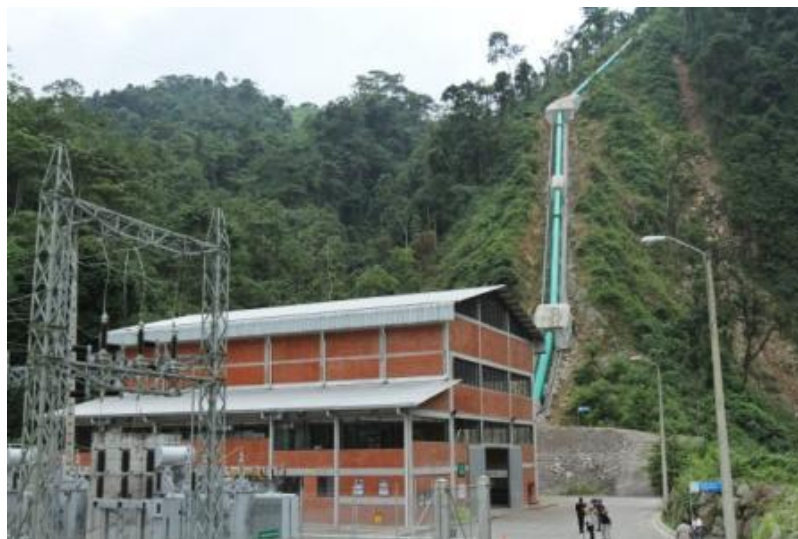
Figura 9. Casa de máquinas de la Central Ocaña
