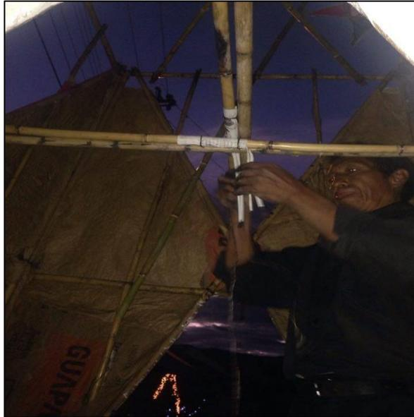
**Ilustración 90 Colocación de mechas Fuente: Autor**
