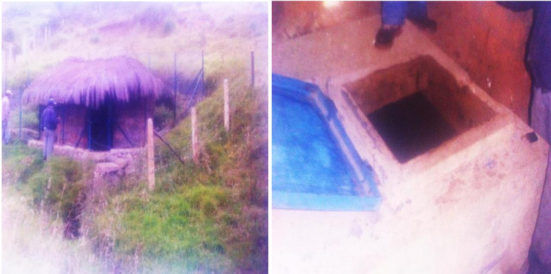
Figura 1.1.13: Captación del sistema actual de agua potable de la comunidad la Esmeralda
