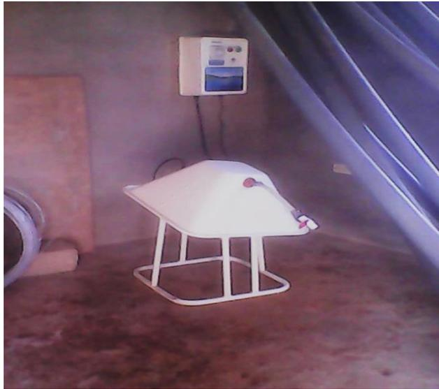
Figura 1.1.17: Equipo de cloración. Clorid L30
