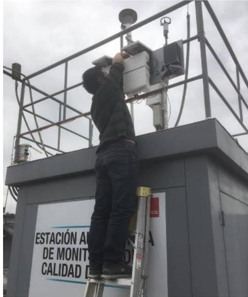
Figura 4.28: Instalación de nodos sensores junto a Estación Automática.
