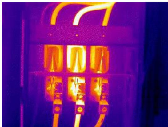
*Fig.3- 6 Análisis Termográfico de un interruptor*
