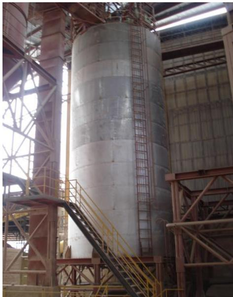
*Fig.1- 11 Silo de almacenamiento principal Capacidad 200 Ton.*
