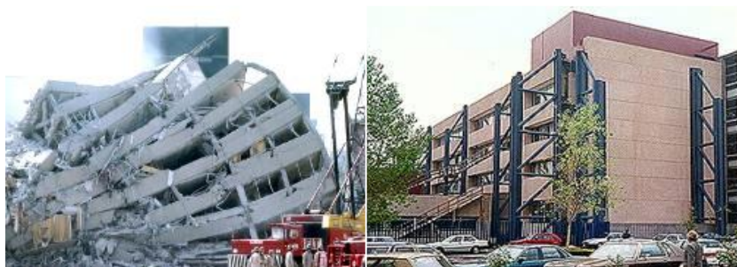
Figura N° 5 Hospital Inseguro vs Hospital Seguro (Fuente: Archivo fotográfico Gestión De Riesgos De Salud IESS)
