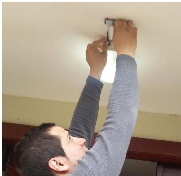
Figura 4.6: Instalación del sensor de presencia en la entrada principal.
