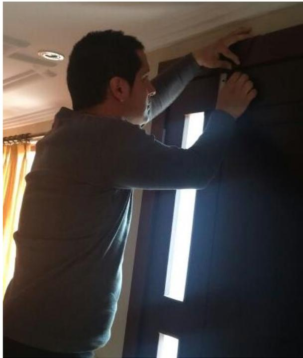
Figura 4.5: Instalación del sensor magnético en la puerta principal.
