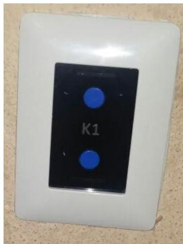
Figura 4.3: Interruptor inteligente instalado.
