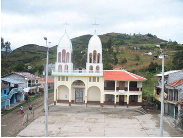
Figura 1.3: Fotografía desde el aire del terreno donde se emplazará la obra
