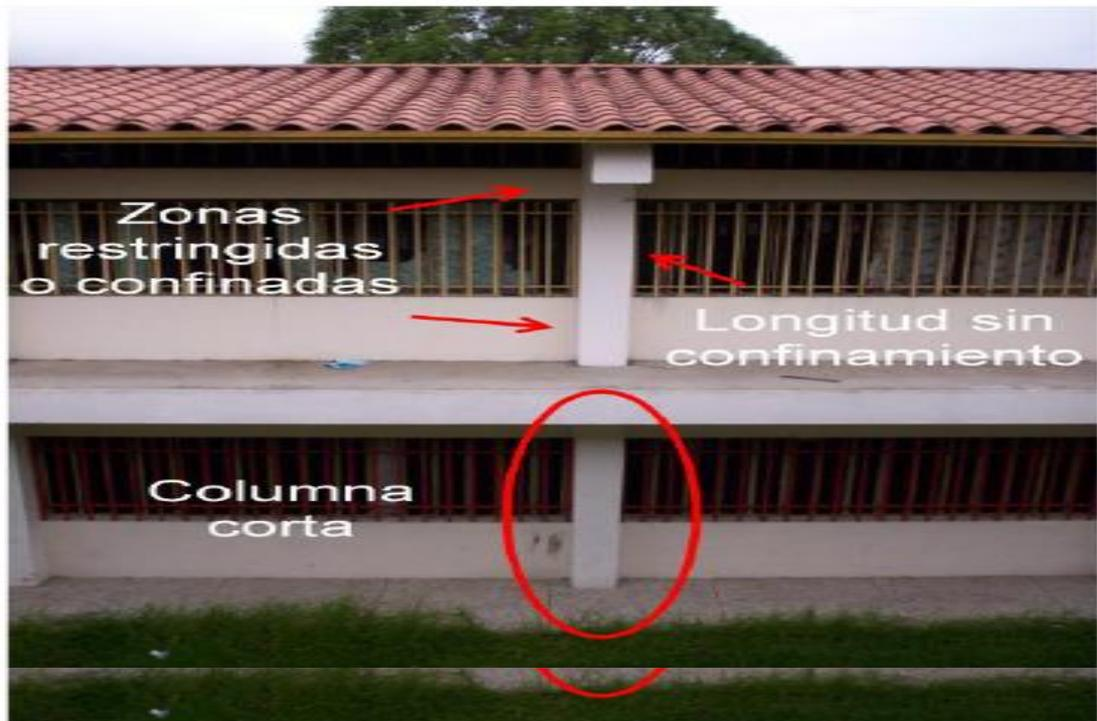
Figura 12: Columnas cortas
