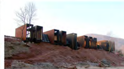
Casa rural - RCR arquitectos. La Vall de Bianya, Girona, España fuente: http://www.plataformaarquitectura.cl/cl/767538/casa-rural-rcr-arquitectes
