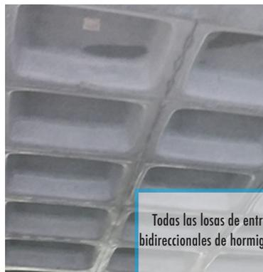
Todas las losas de entrepiso son bidireccionales de hormigón armado.
