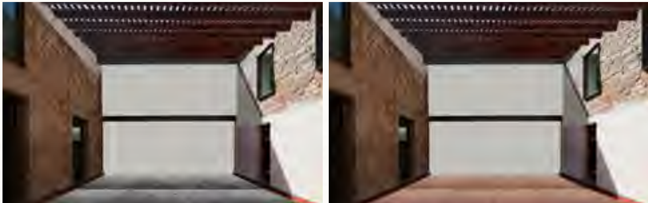
Fig. 61-62 Espacio exterior con pérgola con la colación del piso de cuadrantes.
