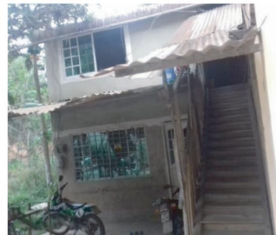
Fig.31 Gradas con peldaños de 0.30cm huella y 0.14cm contrahuella, de tal manera que ayudan a un mejor acceso a la segunda planta
