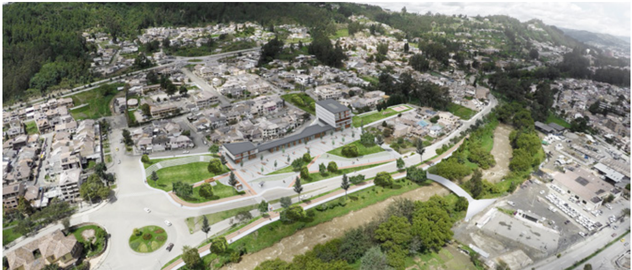
Vista aérea del conjunto y comunicación de espacios verdes.
